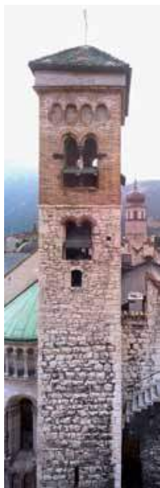
303 Il campanile di San Romedio prima del restauro, con la parte sommitale interessata da problemi statici. Foto da documentazione di progetto
