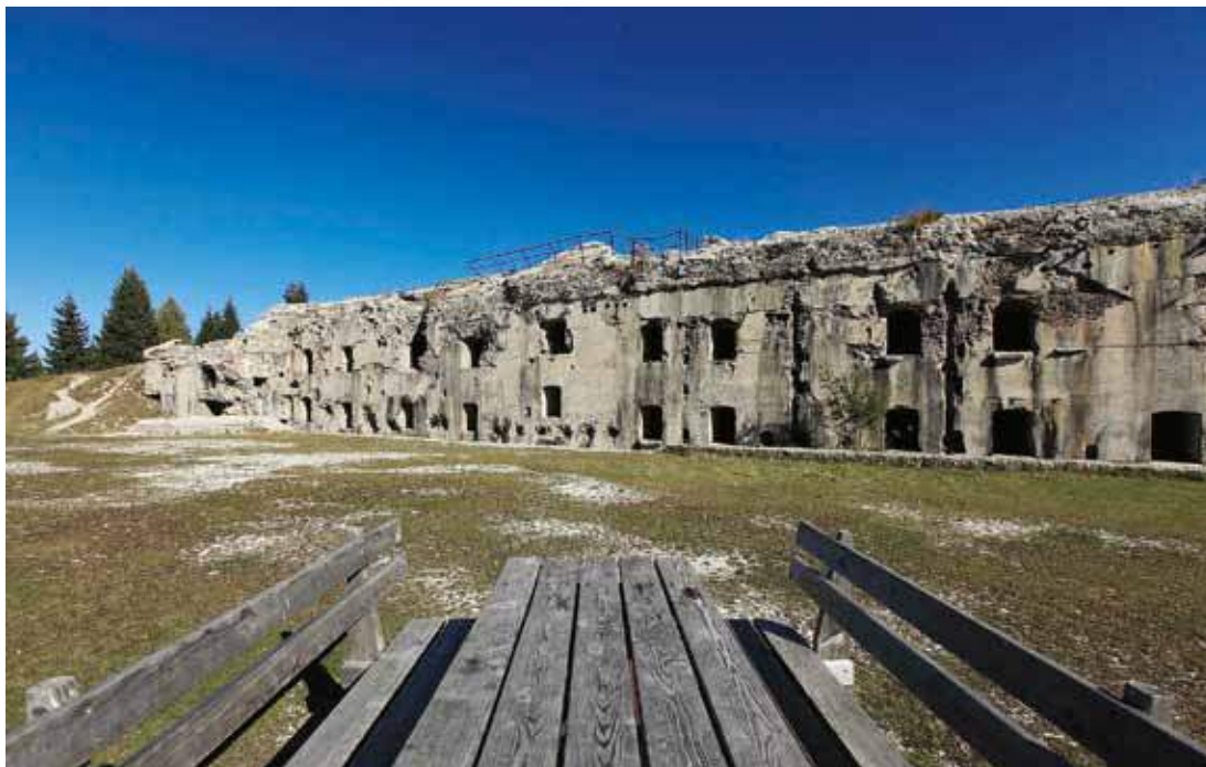
505 Il forte Sommo Alto/ Zwischenwerk Sommo a Folgaria
