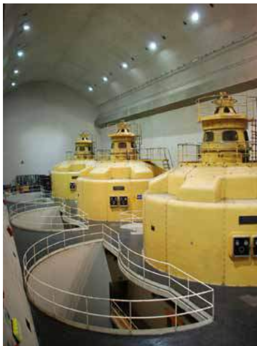
Fig. 164 Impianto idroelettrico sul Noce, blocco della centrale. Progetto del 1920 di G. Ponti, A. Fornaroli, A. Rosselli, C. Martello (diga). Foto di F. Campolongo
