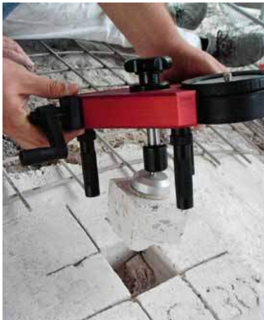
352 Prove di pull-off . Foto di U. Turrini
